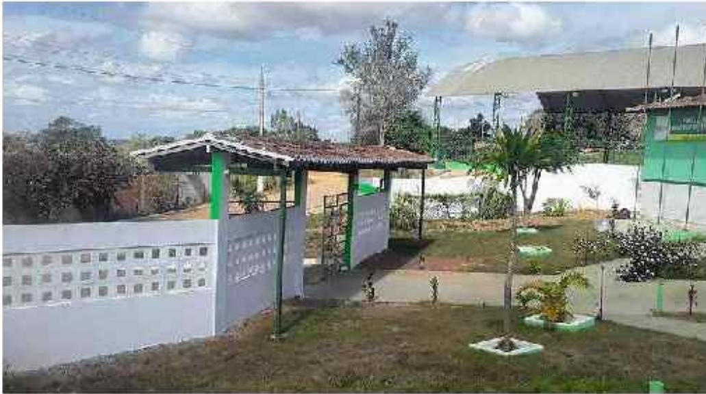
Pintura e manutenção de prédio onde funciona a Sec. Municipal de Educação
