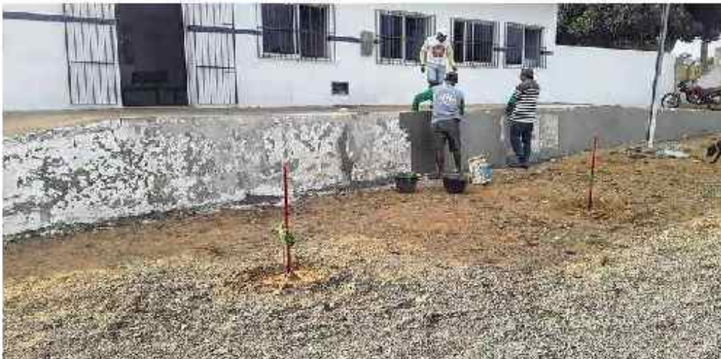
Reforma e ampliação da UBS do Pov. Mocambo
