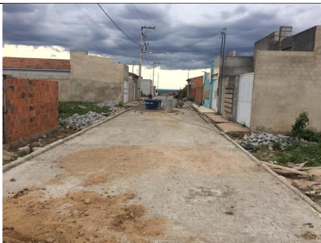
Pavimentação da Rua Projetada 2
