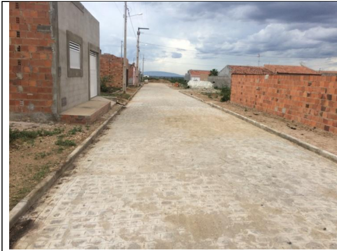
Pavimentação da Rua Projetada 1
