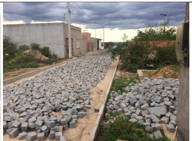
Pavimentação da Rua Projetada 3
