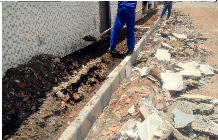
Pavimentação da RUA APARECIDA
