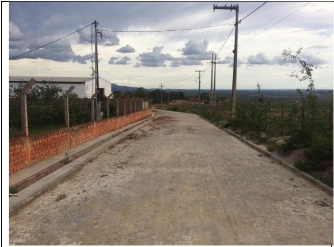
Pavimentação da Rua João Rodrigues Lima
