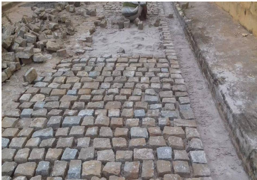
Reposição de pavimento em ruas do Povoado Alagadiço
