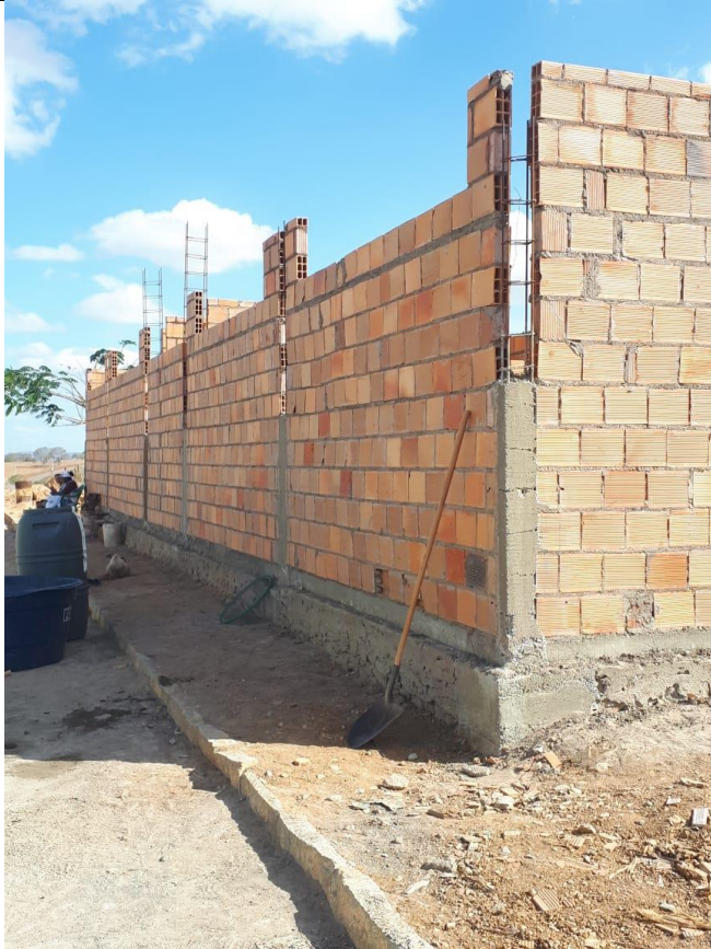
Paredes em alvenaria de vedação do campo de Mocambo.
