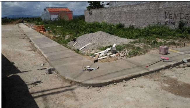
Pavimentação da Rua Projetada 1
