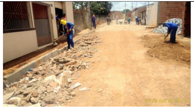
Pavimentação da RUA APARECIDA
