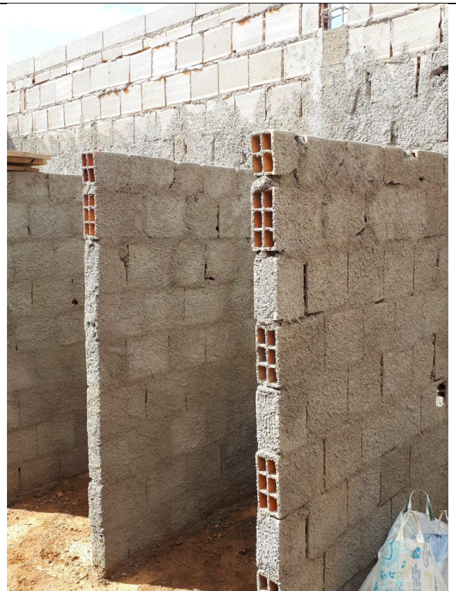
Paredes em alvenaria de vedação do campo de Rua Brasília.
