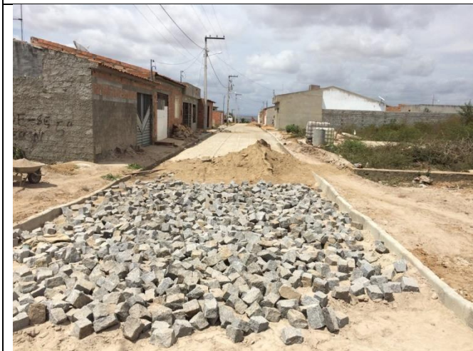
Complemento da Pavimentação da Rua Projetada 4
