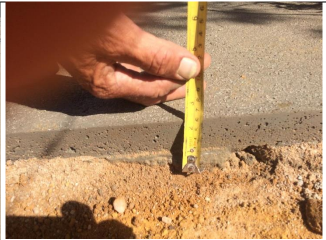
Pavimentação da Rua Mario Almeida Lobão
