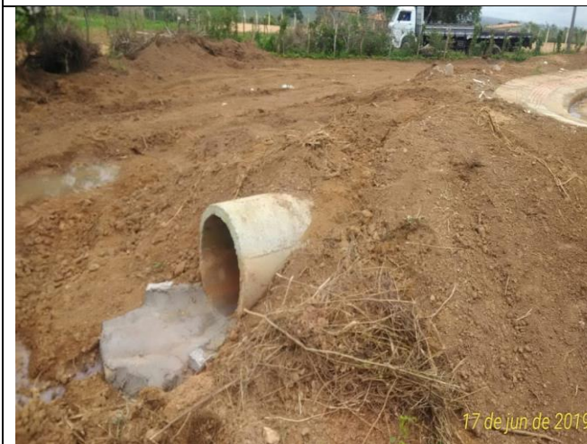
Pavimentação da Rua Projetada 4
