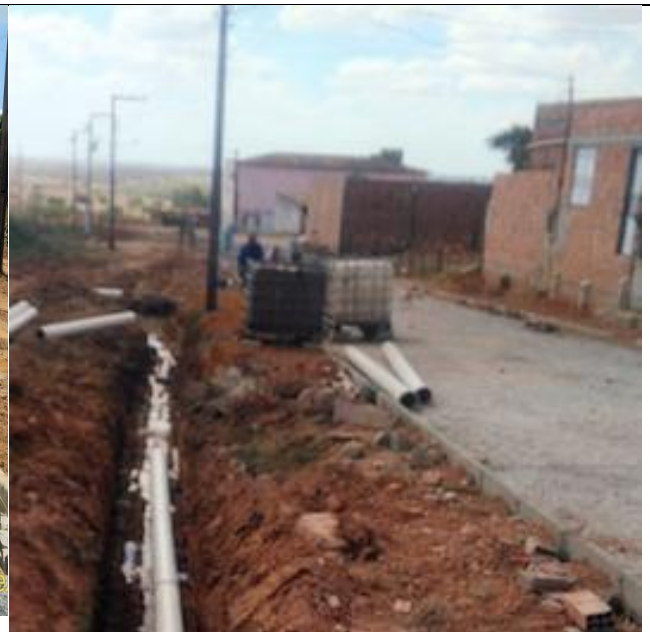
Pavimentação da RUA A. J. ANDRADE
