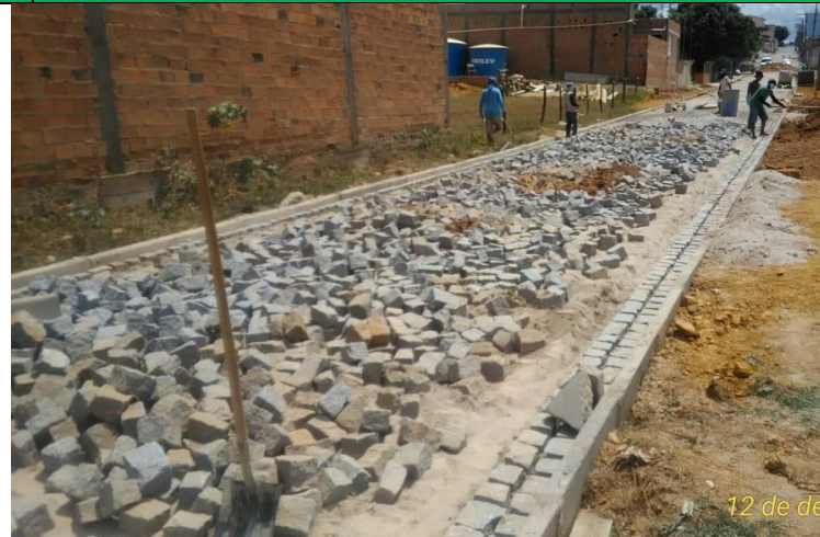
PAVIMENTAÇÃO da RUA A. J. ANDRADE
