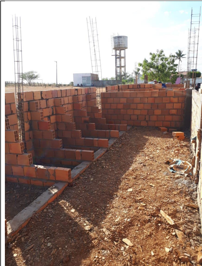
Paredes em alvenaria de vedação do campo de Mocambo.
