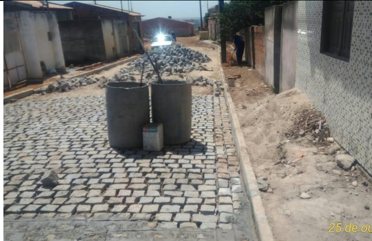
PAVIMENTAÇÃO da RUA APARECIDA
