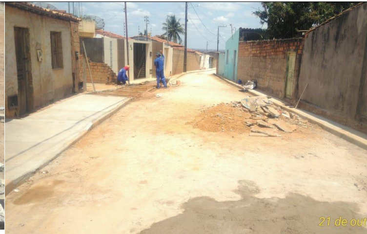
Pavimentação da RUA APARECIDA
