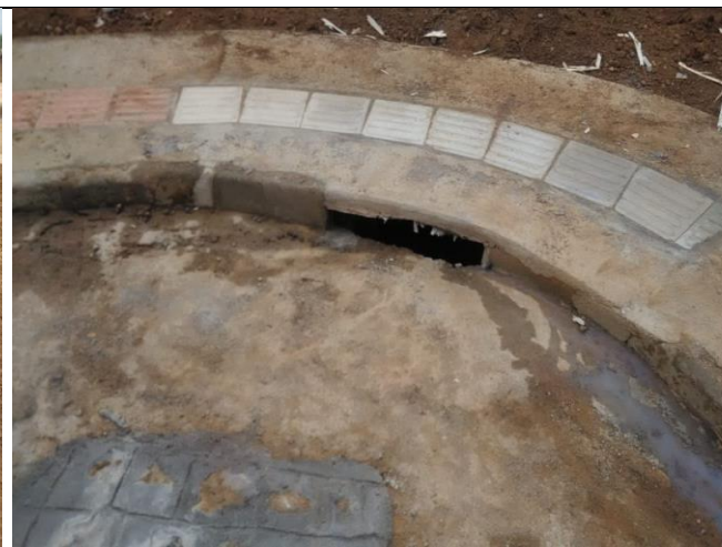
Pavimentação da Rua Mario Almeida Lobão
