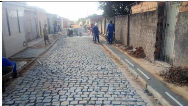
Pavimentação da RUA APARECIDA
