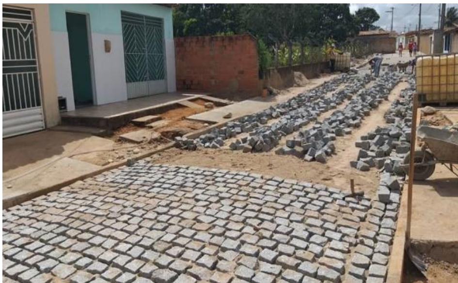
Pavimentação da Travessa Aparecida
